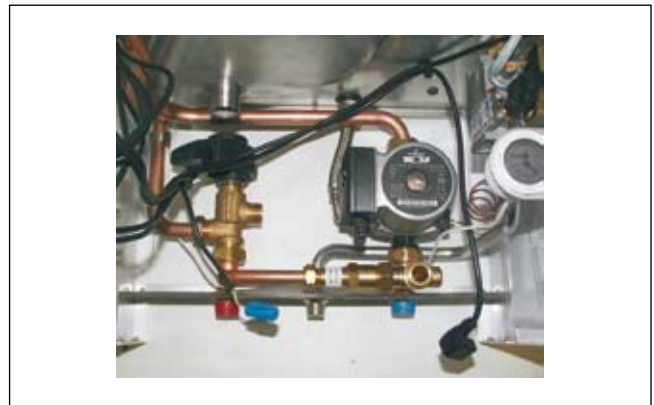
Рис.: Блок подключения демонтирован
