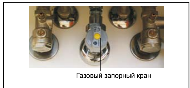
Рис.: Запорная арматура
