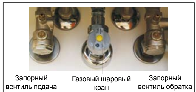
Рис.: Запорная арматура
