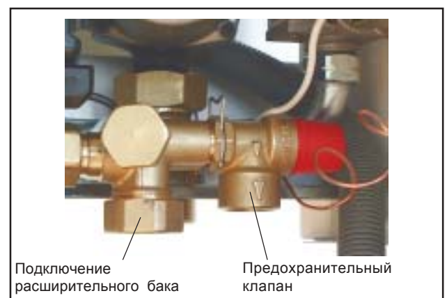
Рис.: Предохранительный клапан, подключение расширительного бака
