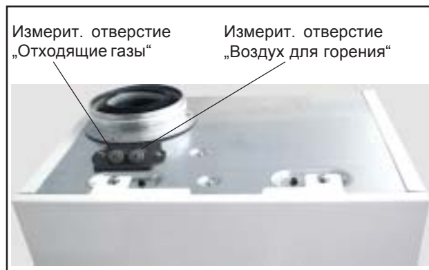
рис: Измерительные отверстия
