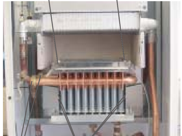
Крепежные болты Компоненты горелки [2]
