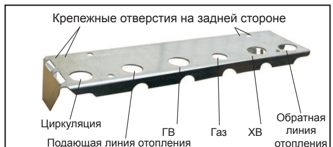
Рис.: Кронштейн каркаса с загнутыми пластинами для открытого монтажа (принадлежность)
