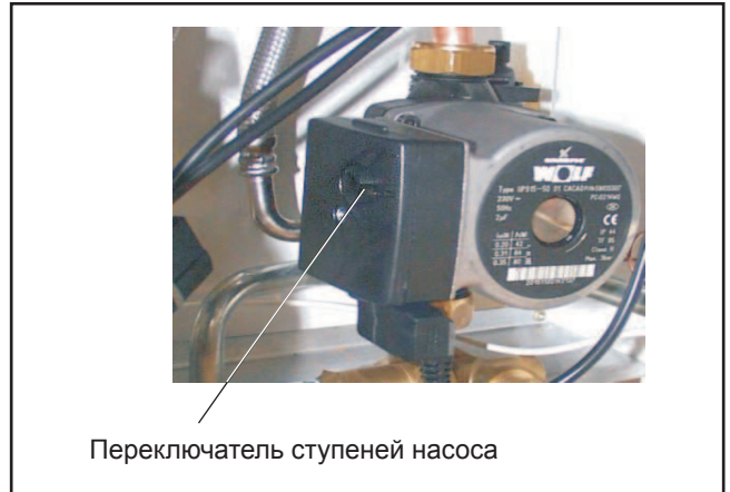
Рис.: Переключатель на насосе нагревательного контура
