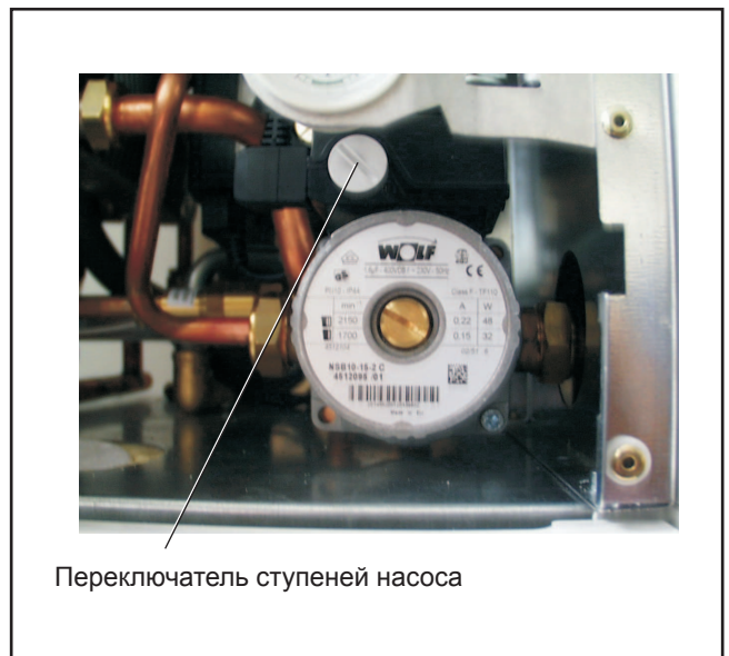
Рис.: Переключатель на насосе загрузки бойлера
