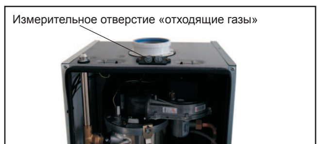
Рис.: Измерение отходящих газов на открытом котле
